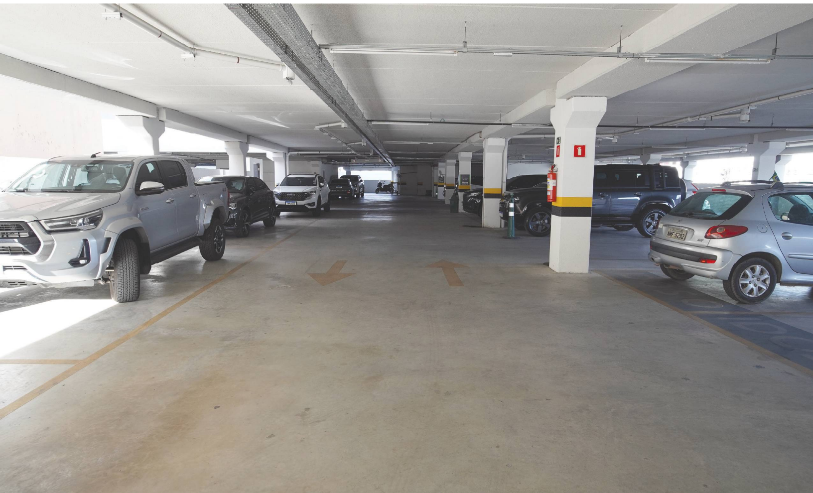
Estrutura conta com 420 vagas distribuídas no subsolo, térreo, primeiro andar, segundo andar e cobertura
